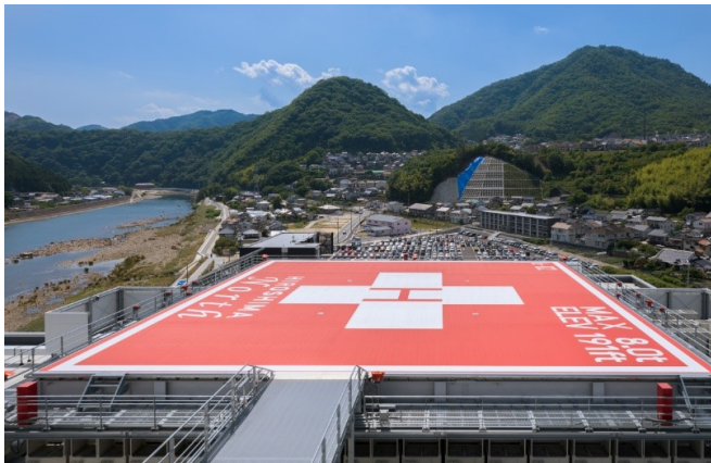
屋上ヘリポート
