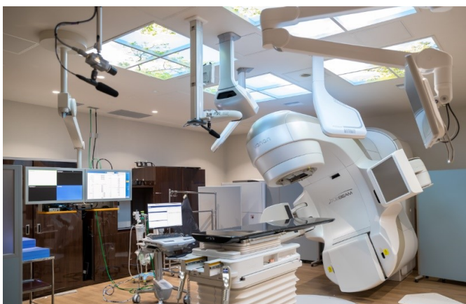
通院治療センター （放射線治療装置）
